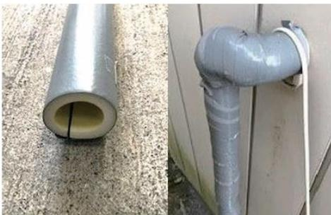
Para evitar problemas, como la rotura de la tubería del agua debido a la congelación, cubra la tubería de agua expuesta al suelo con un material termoaislante, como el estirol espumado.
